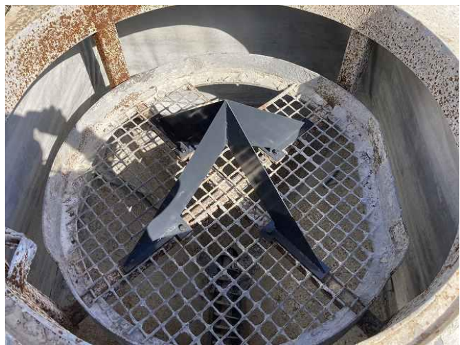
固化材ホッパートンバックカッター欠品の為、取付
