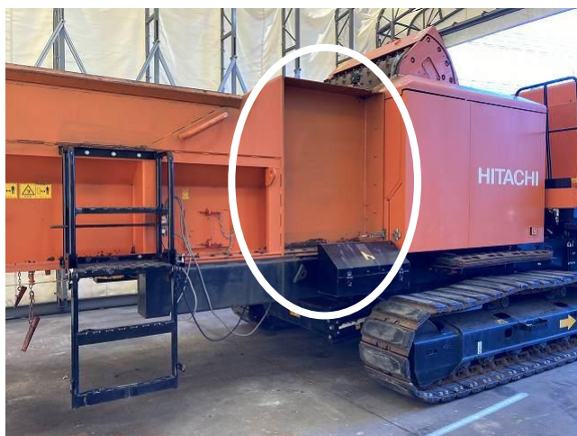
フィーダーデッキ1m延長加工(白線部)
