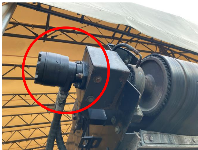
コンベヤモーター1ヶ交換
