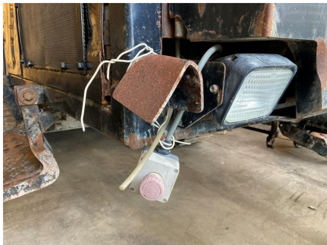
非常停止ブラケット破損
