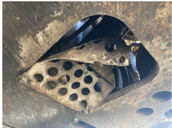
底板カバー変形
